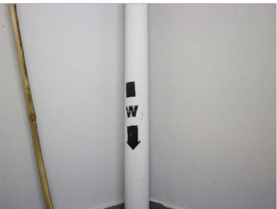
รูปที่ 2-40 ท่อระบายน้ำภายในห้องพักขยะ
